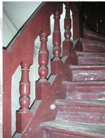
L'escalier du 17 ème avec une rampe sur rampe à balustres chantournés (en bon état de conservation)
